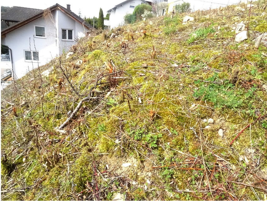
Abbildung 4: Mittlerer Hangabschnitt von Osten (März 2024)
