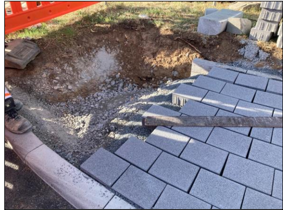
Bsp. Talheim (2020) Bauphase erkennbar: mit Vorsatz geformte Betonsteine
